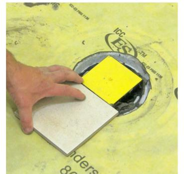
20. A l'aide d'une truelle de bordure ou d'une petite lame plate, enfoncer du mortier-colle modifié de haute qualité dans la poche et dans les rainures de verrouillage de l'anneau de verrouillage de la colonne montante. Ce procédé permettra les ajustements finaux tout en permettant un assemblage de contremarches et de grilles super solides, résistantes et bien supportées après le durcissement de la couche mince.
