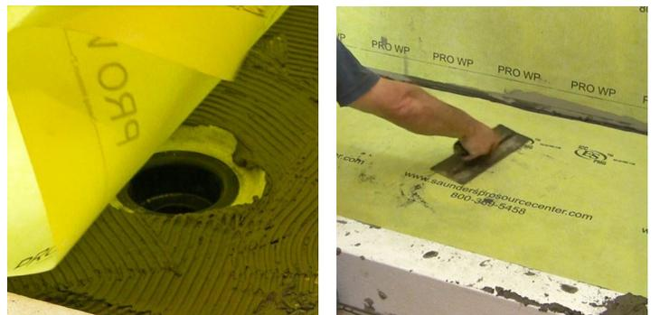
17. Découper soigneusement la membrane recouvrant l'évidement de la bride centrale à l'aide d'un couteau utilitaire bien aiguisé. Utiliser le bord droit d'une truelle pour s'assurer que la membrane au bord de la coupe reste bien collée à la bride.
