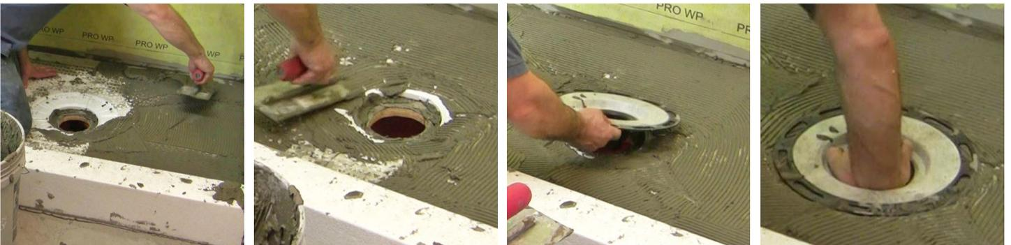
16. Enlevez maintenant à la truelle le ciment-colle modifié dentelé de 3/16 po sur la zone "non-tissé" de la bride de vidange. Cependant, NE PAS encore appliquer de ciment-colle sur l'évidement de la poche centrale de la bride. Positionner, enfoncer et poser la (les) pièce(s) de plancher en utilisant les mêmes techniques d'installation que celles utilisées précédemment.
