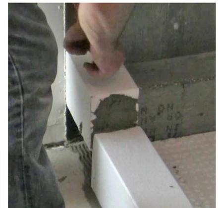
9. Installez à sec votre bride de vidange dans la poche en mousse et sur votre tuyau de plomberie de 2" de diamètre. La bride GEN II possède des rainures de verrouillage intégrées dans le fond. Il suffit d'appuyer littéralement sur la bride de vidange pour forcer les rainures de verrouillage dans la poche en mousse afin de garantir un siège parfait pour l'installation finale. A ce stade, il suffit de laisser la bride ajustée à sec en place.
