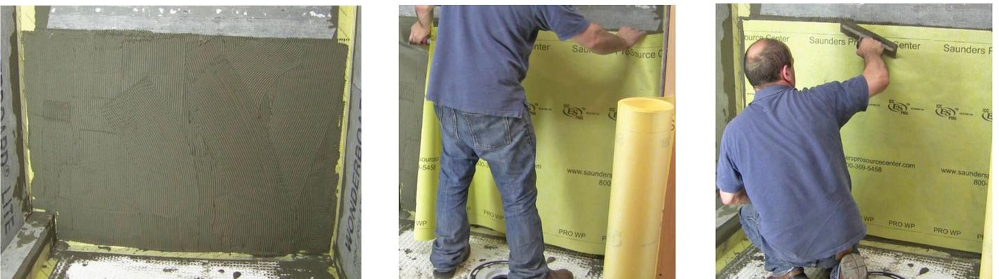
Le reste de l'installation va suivre la même séquence de procédures d'installation. Pour assurer la continuité de l'imperméabilisation, chaque nouvelle section chevauchera la précédente de 2 pouces. La membrane WP est munie d'une ligne pointillée près du bord qui sert de guide pour vous aider à l'installer correctement.
